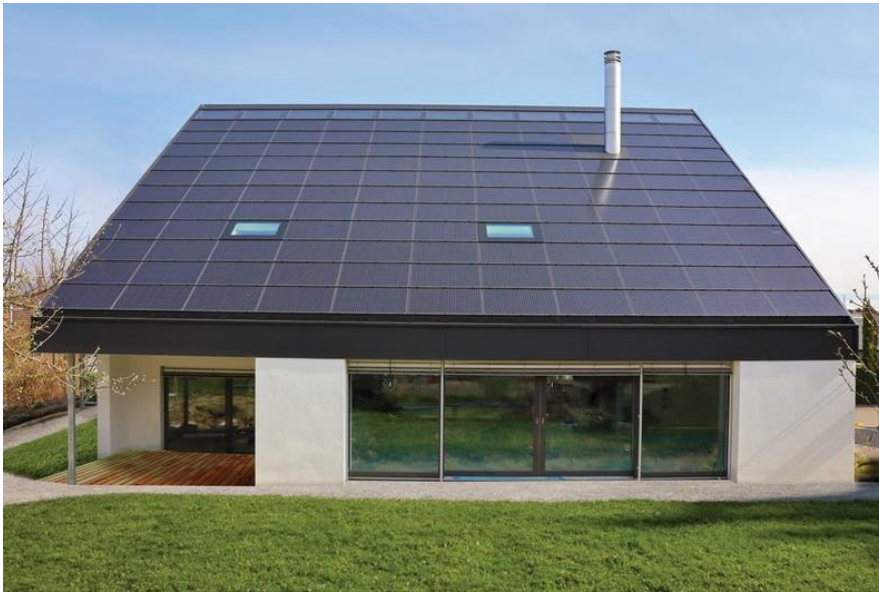
Sauber integrierte Photovoltaikanlage mit bündigem Randabschluss und minimaler Rasterzeichnung.
