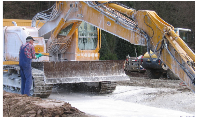
Vorgängige Desinfektion von Baumaschinen, welche in Gewässern mit heimischen Flusskrebsen zum Einsatz kommen. Foto: R. Hennings
